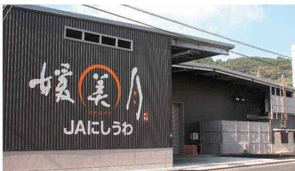
完成した八協カラーリング施設
