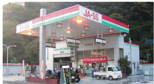
リニューアルオープンした三崎給油所
